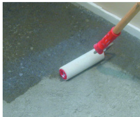
Auftragen von Primer G mit der Rolle
