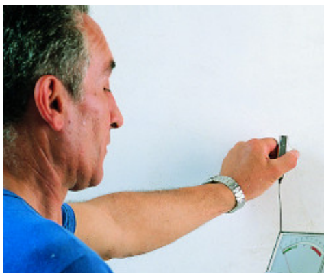
Feuchtemessung des Putzuntergrundes
